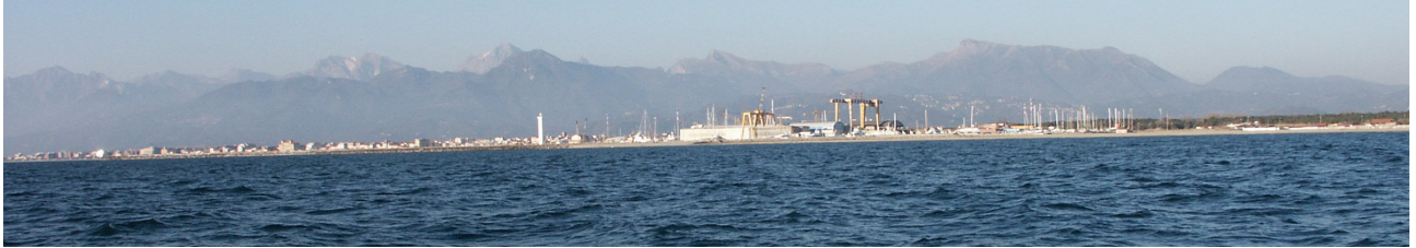
Foto 6 – Water-front del porto
